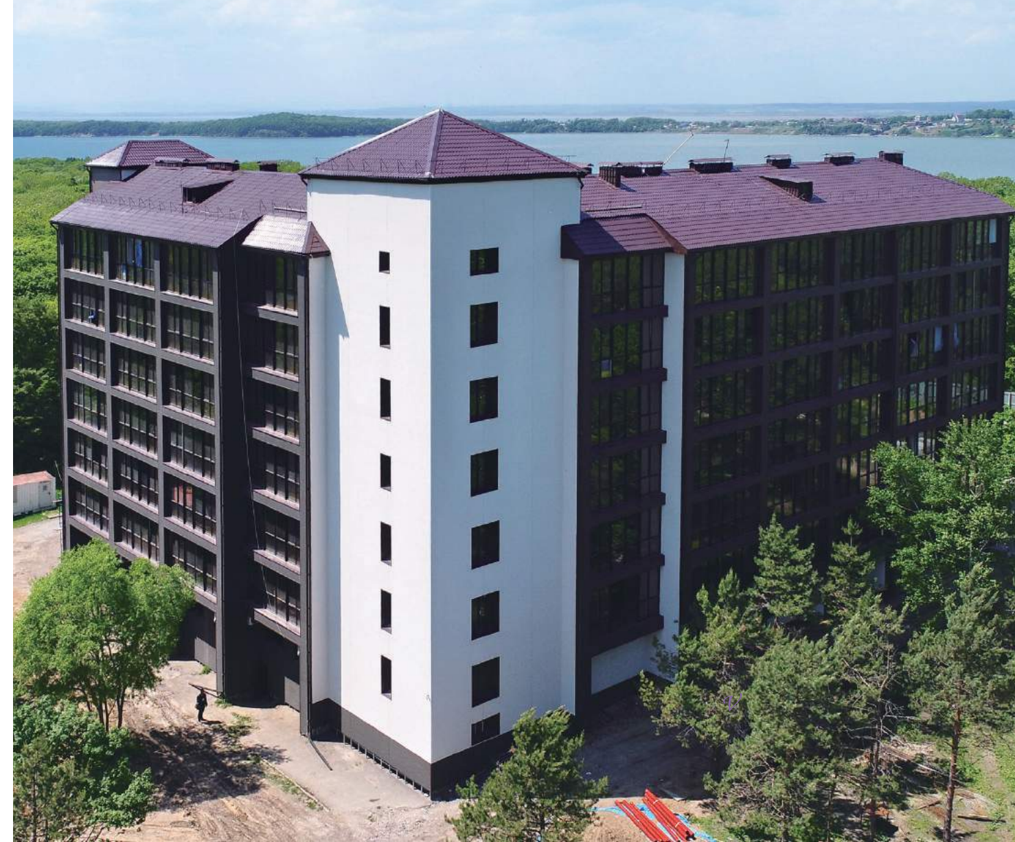
Санаторий РЖД «Экспресс» г. Владивосток NW3841A NW3843A NW3844A
