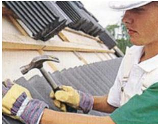
**4** На скатах с уклоном от 12° до 45° черепицу крепят по периметру плоскости кровли. При уклоне от 45° до 60° черепица крепится по периметру, а внутри периметра в шахматном порядке.
