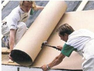
**1** Гидроизоляция настилается прямо на стропила в горизонтальном направлении вдоль карнизного свеса с провисом и крепится степлерными скобами.
