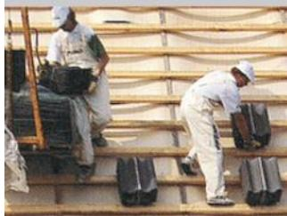
**2** Монтируются вентиляционные проходы и обрешетка. Черепица поднимается на крышу с помощью подъемного устройства транспортной машины.
