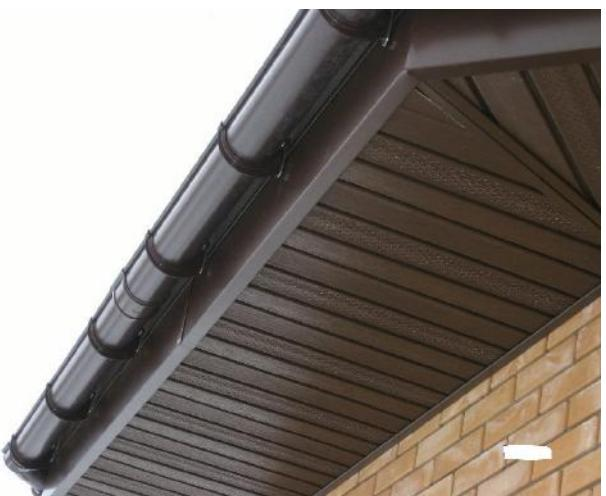
Перфорированный вентилируемый софит как раз тот кровельный элемент, который может обеспечить беспрепятственный проход воздуха через себя и обеспечить циркуляцию воздуха под крышей.
