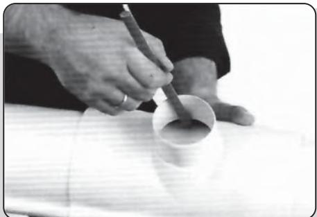
**Монтаж стыковочного элемента, состоящего из муфты с двумя резиновыми уплотнительными поясками и внутренней скобой:**
