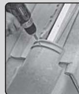
Просверлить желобчатую черепицу с головной частью, установить для покрытия и прикрепить к обрешетке крыши саморезом.
