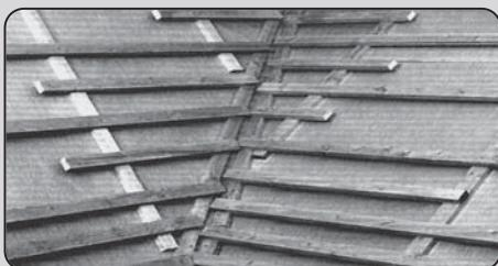
**Важно!** Не допускается укладка желобка ендовы на сплошной настил из досок по уровню контробрешетки без вентиляционного зазора снизу.
